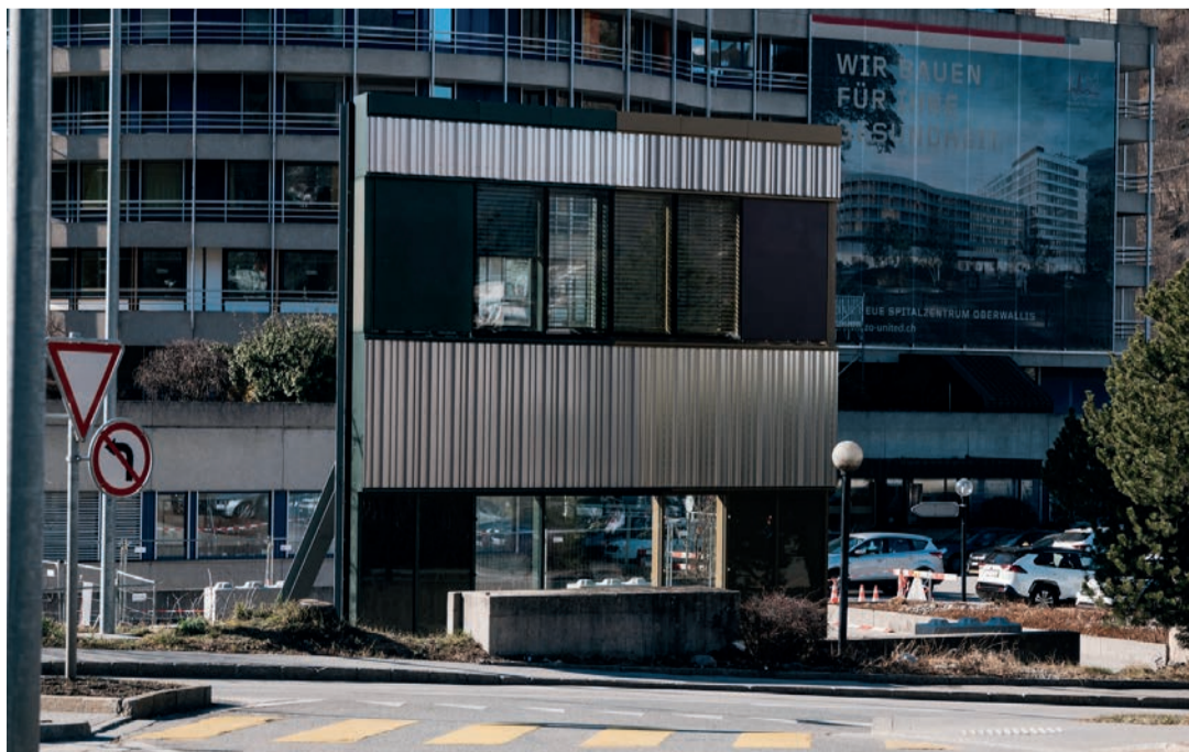
Ambitioniert: Bis Ende 2024 soll der Rohbau des neuen Spitals stehen.
